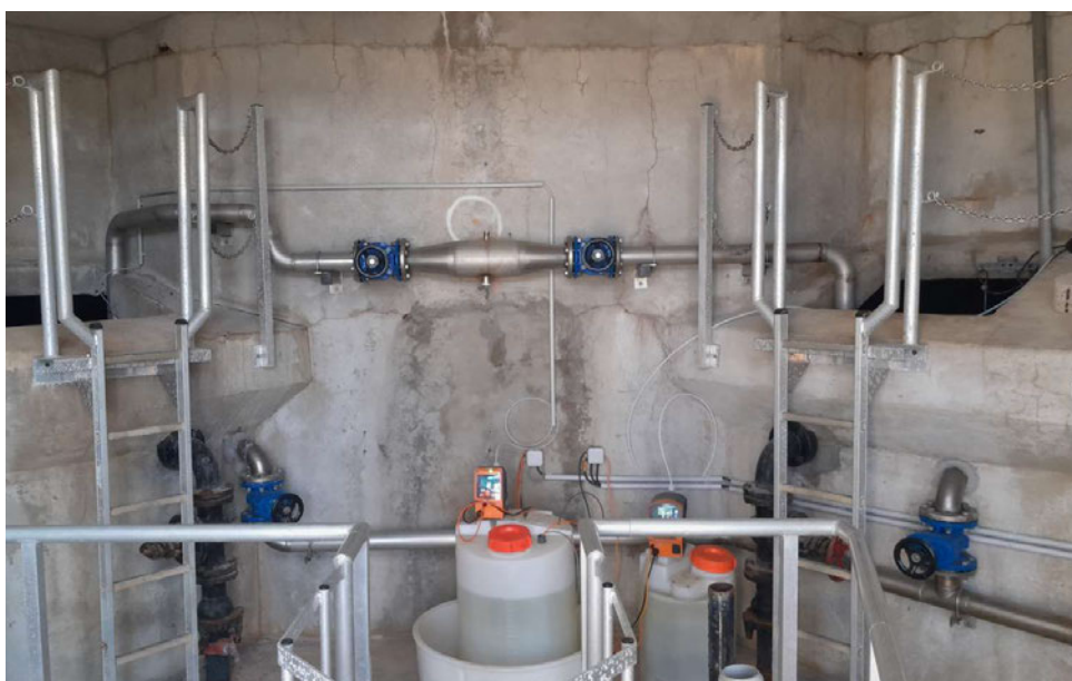
Réservoir de Mouleyras :
